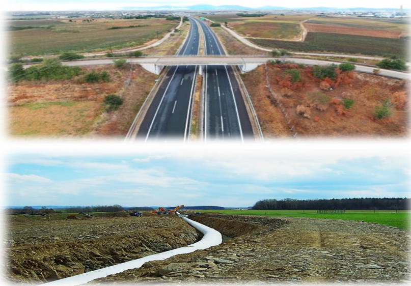
Фигура 6. Нарушения на почвената покривка при изграждането на магистрали и тръбопроводни трасета
